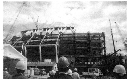
平成7年12月 (リフトアップ 重量 10,300t ジャッキ 72台)
