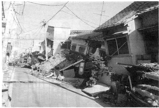
住吉町附近の惨状 見渡す限り被害のない建物は無い。
